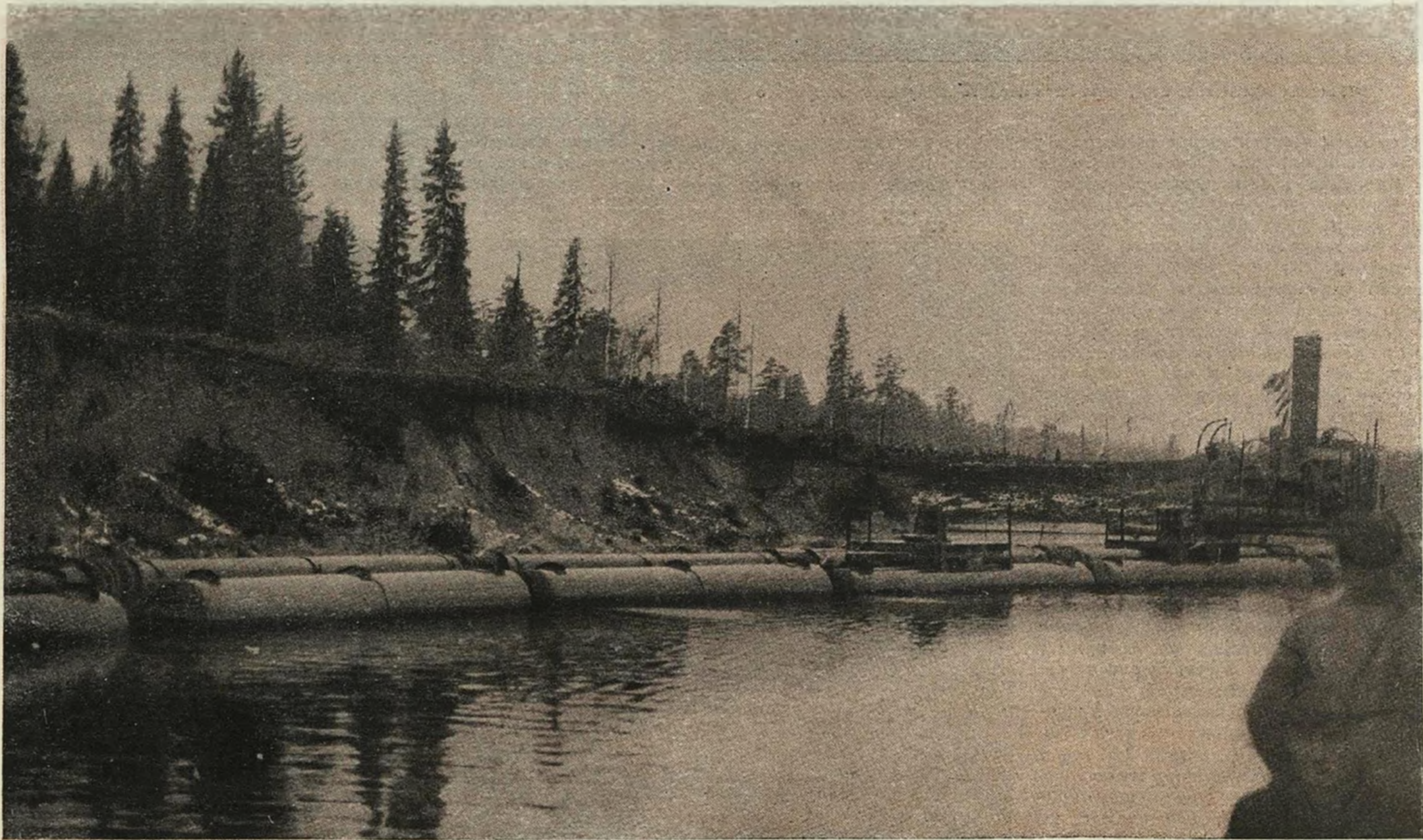
На снимках—река Свирь в том месте, где будет строиться станция. На воде видны землесосы, углубляющие русло реки.
